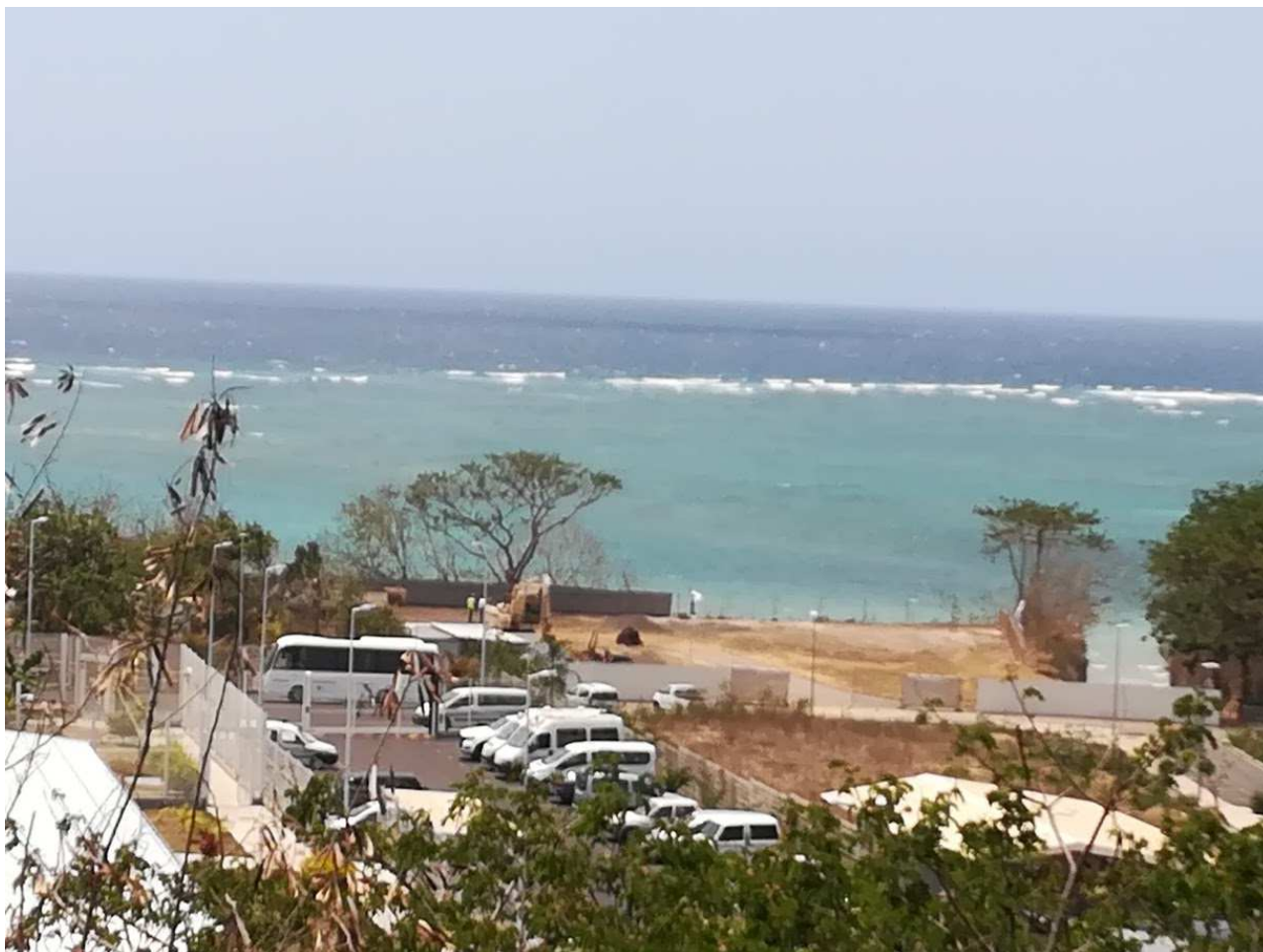
Site de l'extension après démarrage des travaux, le 1er novembre 2017 - Photo Deal G. Chapelier -
