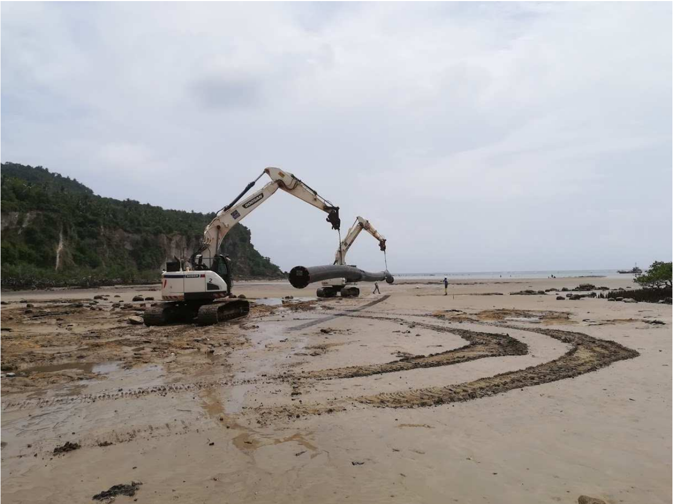
Chantier conduite prise d'eau - 17 janvier 2017 - visite-terrain Deal (G. Chapelier)
